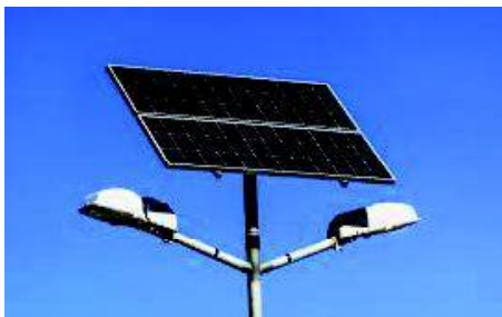
चित्र - 13 : सडकों पर सौर लाइटें
